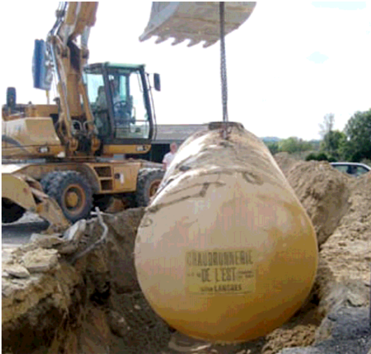
Pose de la cuve double paroi Source : Garage Daugrain - Barbuise
